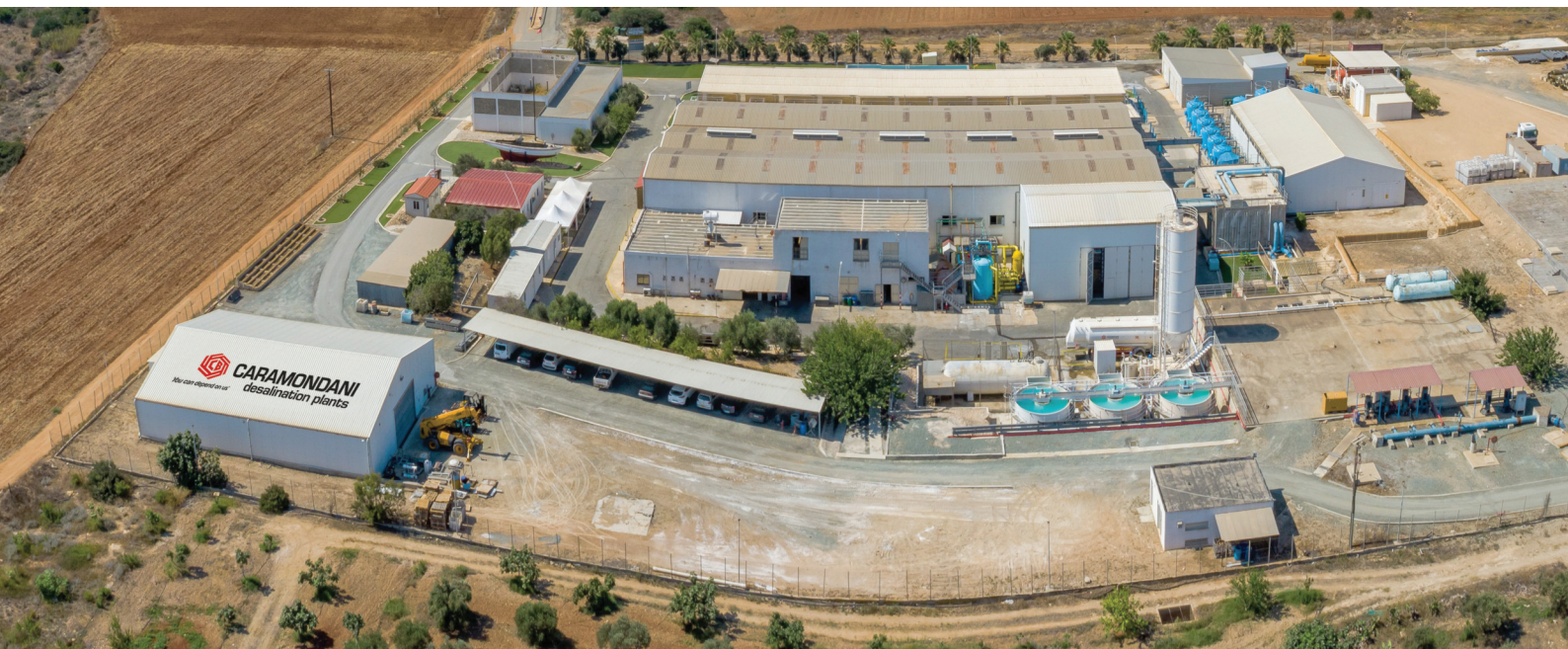
Εργοστάσιο Αφαλάτωσης Δεκέλειας, Κύπρος – έργο αναφοράς Ομίλου Caramondani Δυναμικότητα: 60.000 m 3 /ημέρα
