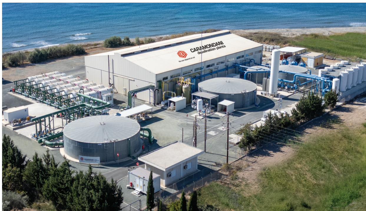
Εργοστάσιο Αφαλάτωσης Πάφου - Κύπρος SWRO, δυναμικότητα 15.000 m 3 /ημέρα, πόσιμο νερό, σύμβαση BOOT
