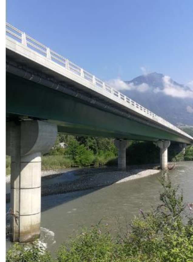
Tournon Viaduct – Savoie – France Itinero®
